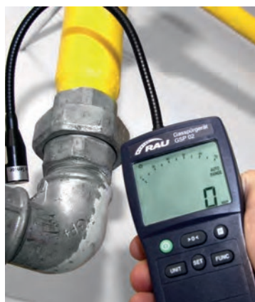
Slika lijevo: Provjera nakon montaže brojlja
