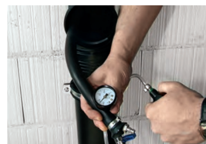
Pumpanje ispitnih balona s mijehom za puhanje; ispitni balon u otvoru za čišćenje cijevi odvodnje
