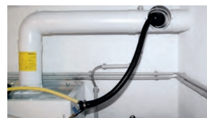
Ispitivanje dimnjaka kondenzacijskog kotla
